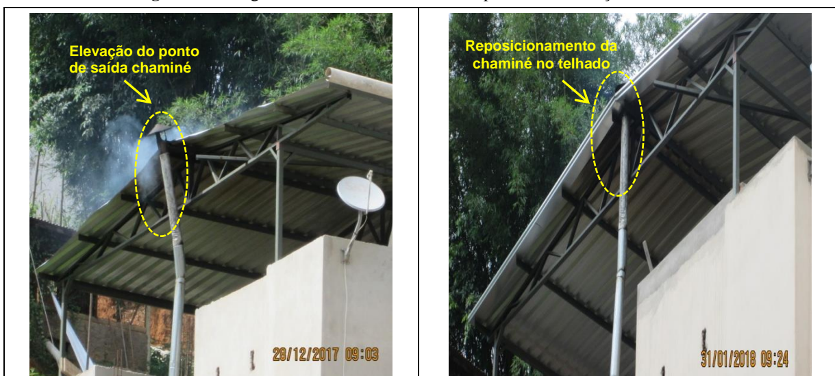
Figura 7.4 - Registro da Chaminé da Padaria Após Nova Alteração da Altura
